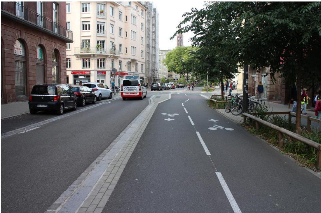
**Abbildung 2.4** Radverkehrsanlage in der Rue de la Brigade Alsace-Lorraine mit Blickrichtung stadteinwärts: Der Sicherheitstrennstreifen mit integriertem Bord zur KFZ-Fahrbahn ist in Pflasteroptik hervorgehoben worden. Bild: Dirk Schmidt 10-2016
