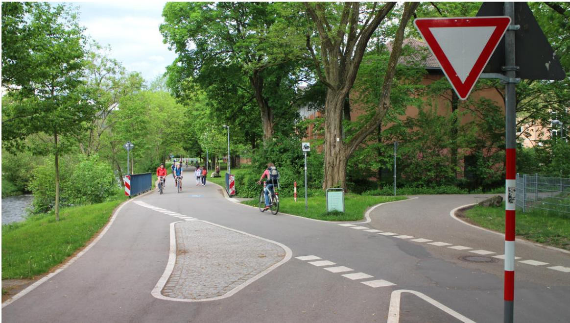
**Abbildung 2.22** Radvorrangroute FR1-Dreisamuferweg: Aus Platzgründen gibt es hier keine Separation des Rad- vom Fußverkehr. Die Hauptstrecke hat an diesem Knoten mit Nebenrouten allerdings per Beschilderung Vorrang erhalten; Bild: Dirk Schmidt 05-2015
