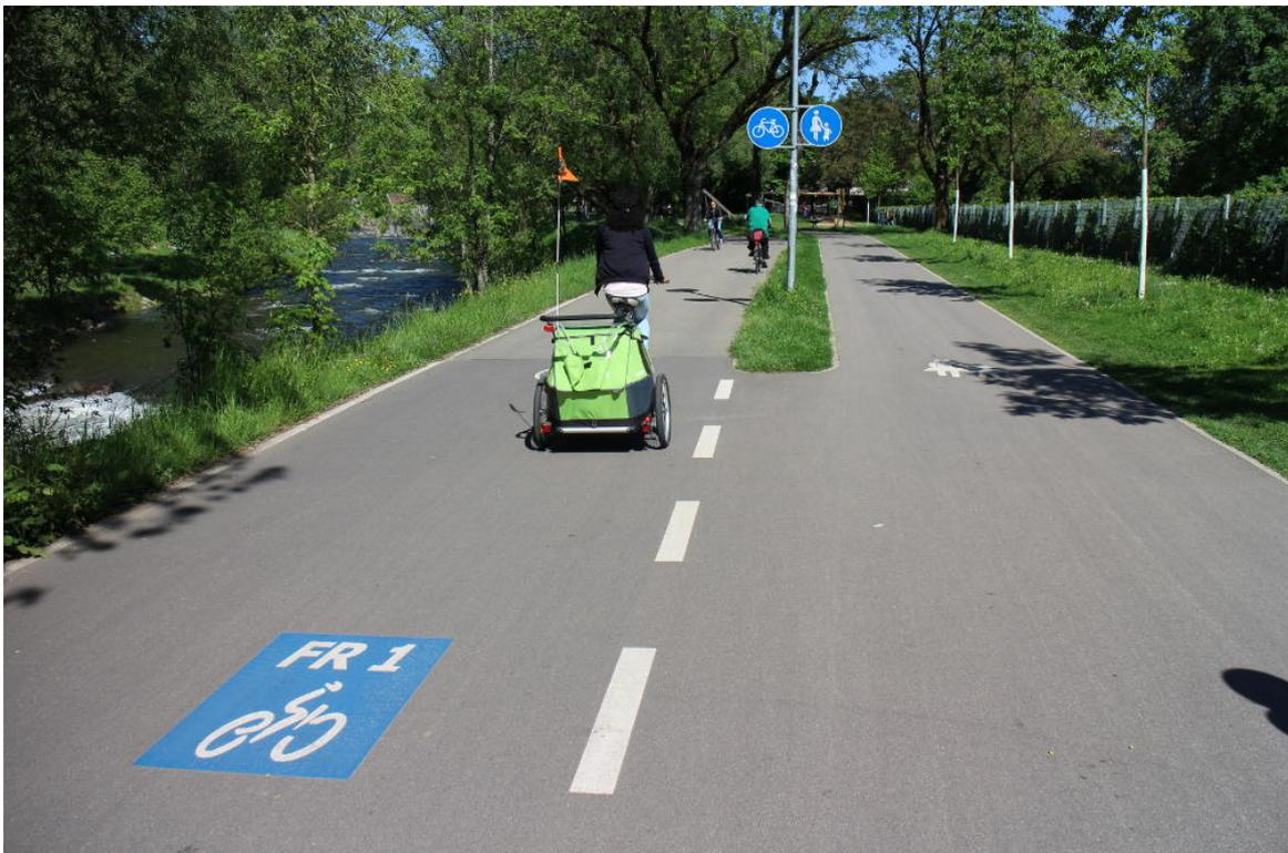
**Abbildung 2.21** Radvorrangroute FR1-Dreisamuferweg: Streckenabschnitt mit neuer, sicherer Trennung des Fuß- und Radverkehrs. Breite Radweg etwa 3 m; Breite Gehweg etwa 2,5 m. Der Gehweg wurde hier abseits des Wassers angelegt, da im weiteren Streckenverlauf in Blickrichtung rechts des Fußwegs ein Spielplatz liegt. Bild: Dirk Schmidt 05-2015.
