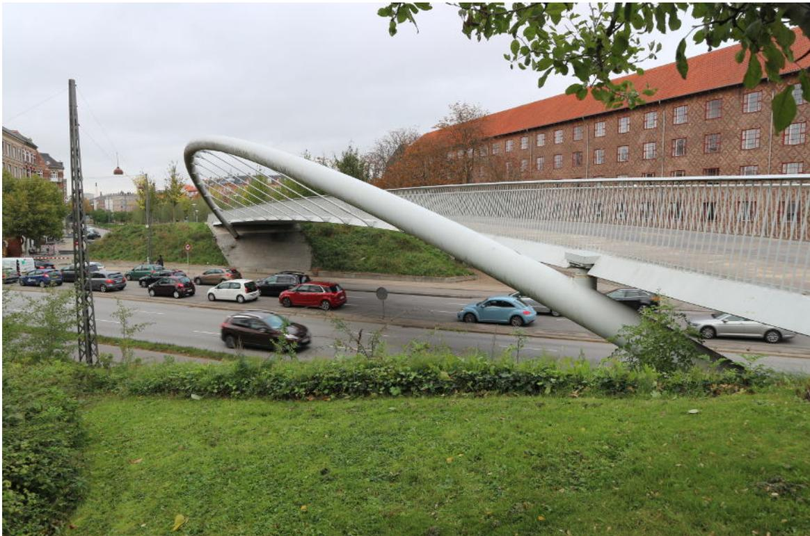
**Abbildung 2.19** Diese Brücke besitzt ein interessante Konstruktion: Das Tragwerk liegt außerhalb des Brückendecks. Bild: Dirk Schmidt 10-2018
