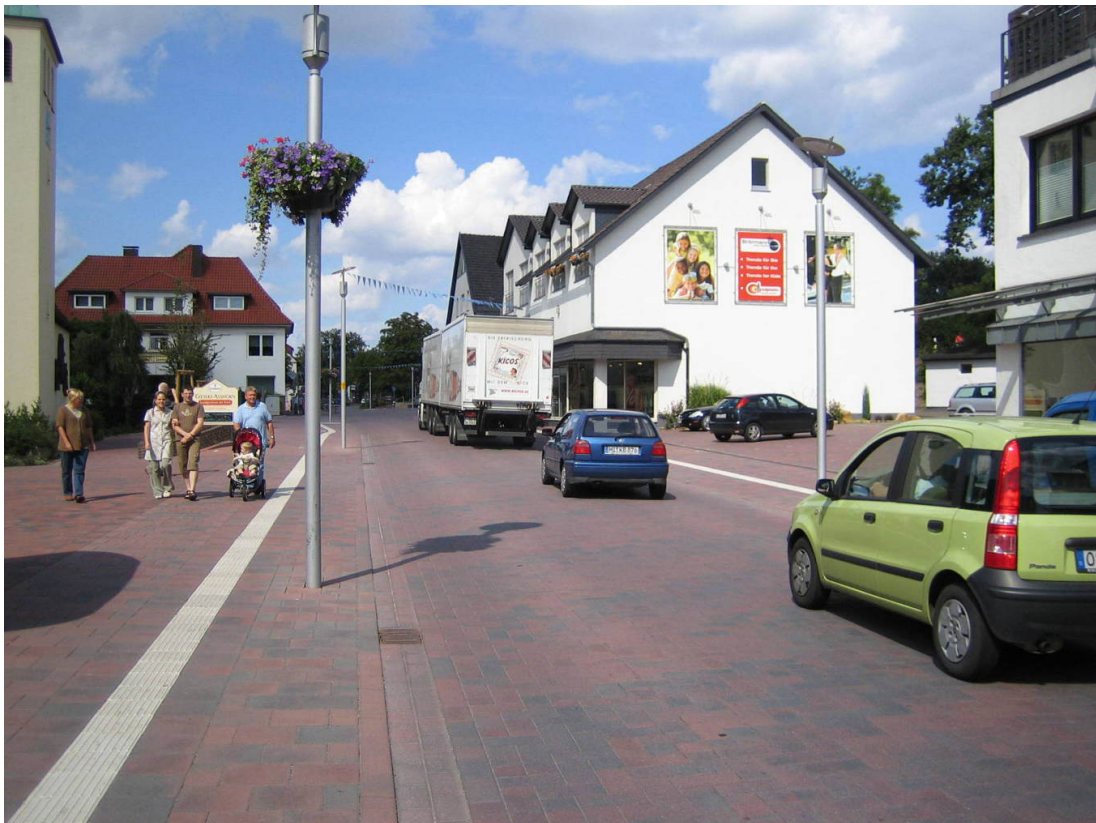
Abbildung 3.9 Durch die Entwässerung und das taktile Leitsystem besitzt die Verkehrsfläche real durchaus eine Gliederung in "Fahrbahn" und "Fußgängerbereich". Der Bereich zwischen Leitsystem und Entwässerung erscheint so etwas als "Parkstreifen". Bild: Swen Schneider 08-2008.
