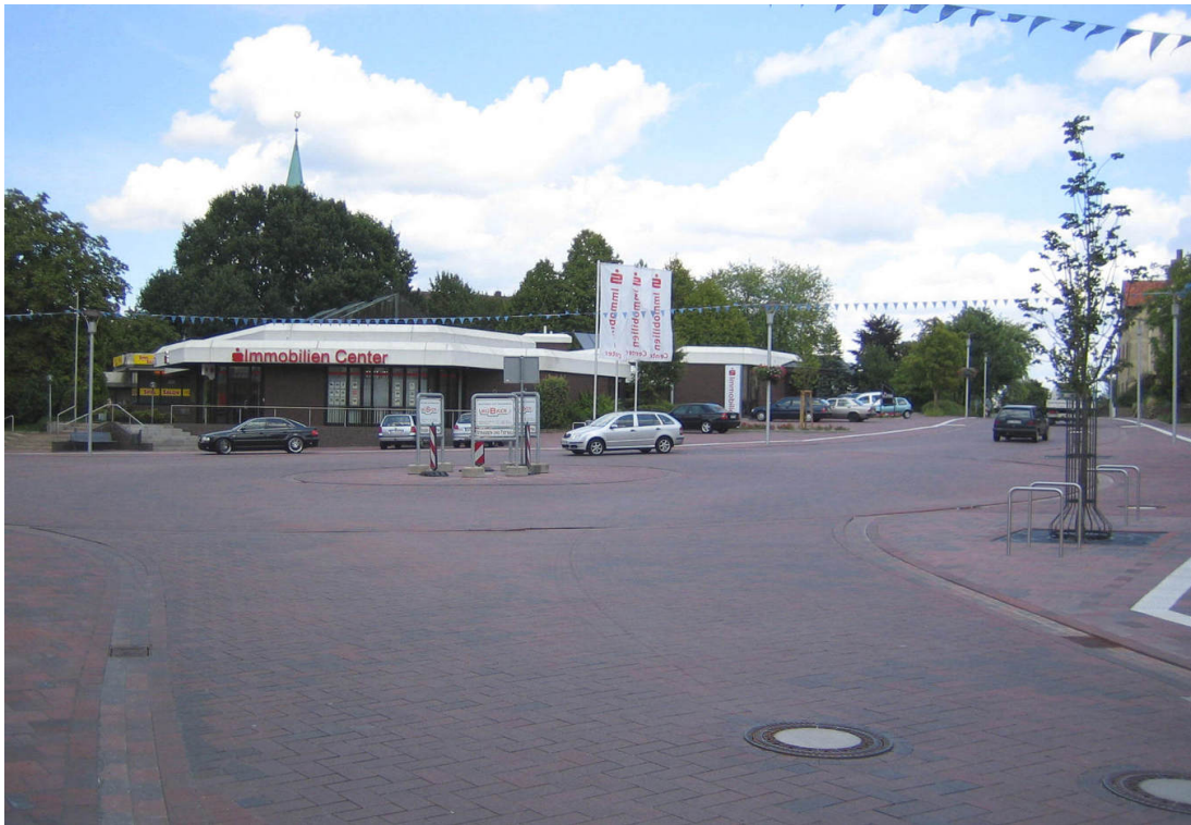
Abbildung 3.10 Im Bild ein Teil der umgebauten Ortsmitte mit kreisverkehrsartiger Shared Space Fläche. Obwohl die Situation wie eine Art „Kreisverkehr“ wirkt, gilt hier die allgemeine Verkehrsregel „Rechts vor Links“ bei Tempo 50 (da entsprechende Verkehrsschilder fehlen). Motiv bei Geo 52.36793 8.31354; Bild: Swen Schneider 08-2008.
