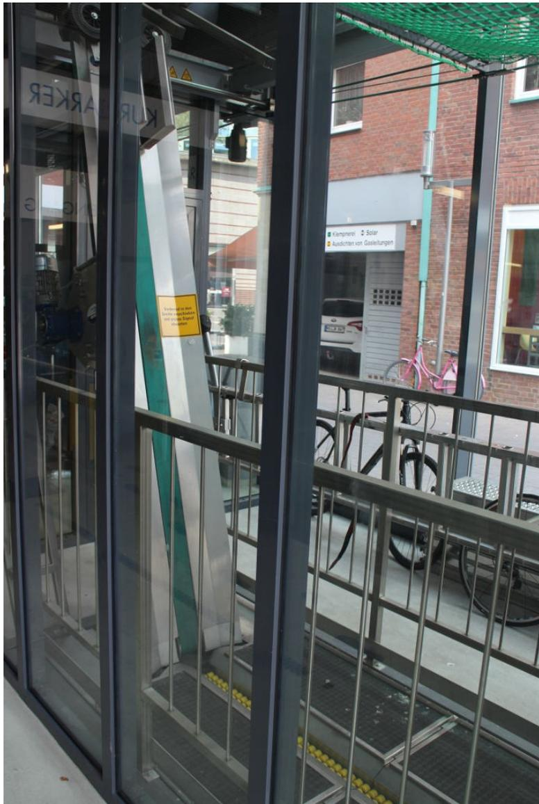
**Abbildung 5.12** Der automatische Fahrradförderer. Bild: Dirk Schmidt 08-2016
