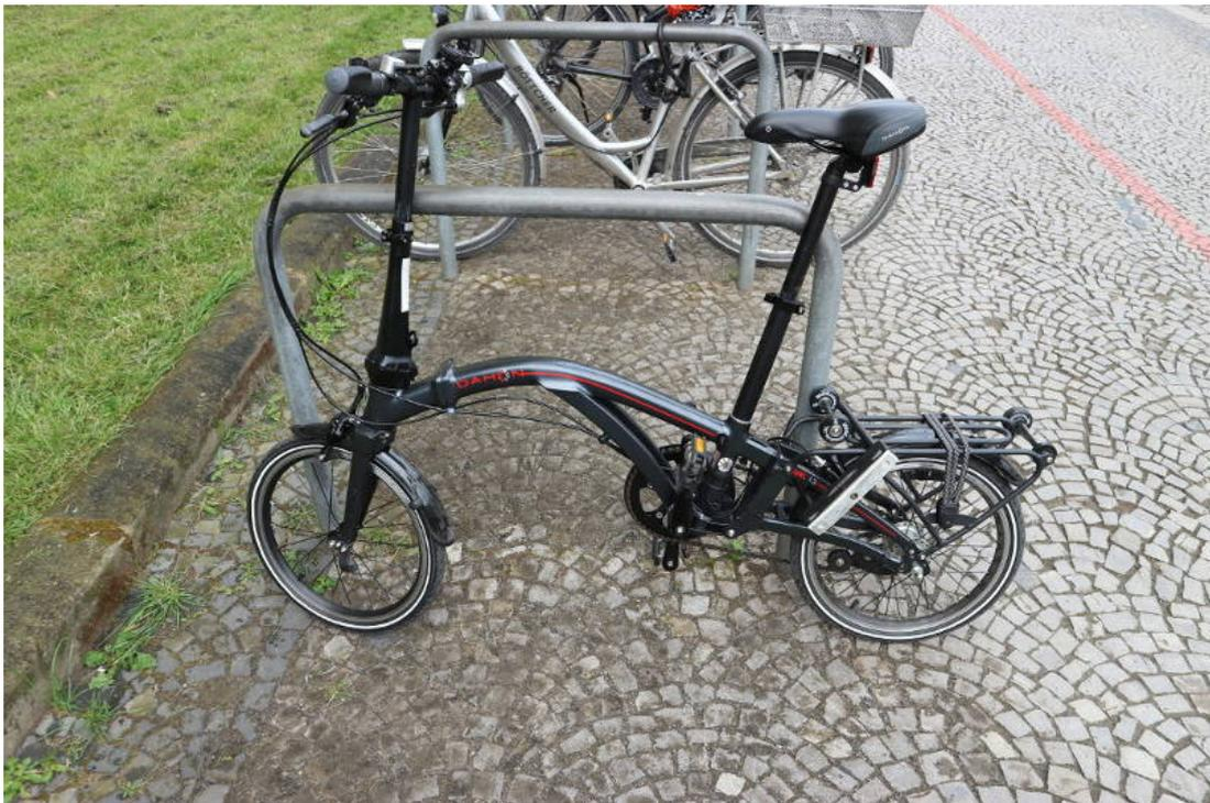
**Abbildung 2.7** Klassischer Bügelständer: Hier Kompaktfaltrad „Curl“ an einen einfachen Fahrradbügel vor dem Rathaus Hannover (verzinkte Stahlausführung). Der Fahrradrahmen konnte mit einem relativ sicheren, hochwertigen Bügelschloss am Ständer angeschlossen werden. Bild: Dirk Schmidt 06-2018
