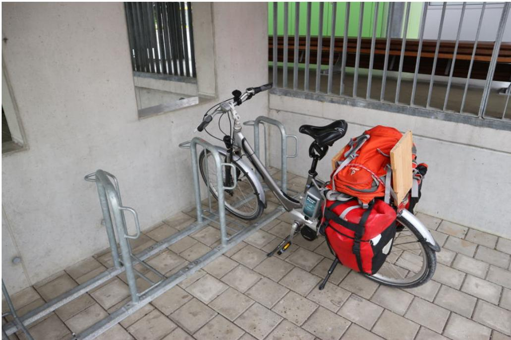
**Abbildung 3.13** überdachte Fahrradständer im Detail: für schwerer bepackte Reiserräder leider zu wenig Halt. Hier wären klassische Anlehnbügel besser gewesen. Bild: Dirk Schmidt 09-2017
