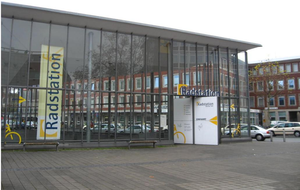
**Abbildung 5.8** Blick auf den oberirdischen Teil der Radstation Münster am HBF. Im Glasbau führt die Rampe zu den unterirdischen Stellplätzen abwärts (Geo: 51.95635 7.63412 Bild: Dirk Schmidt 11-2007).
