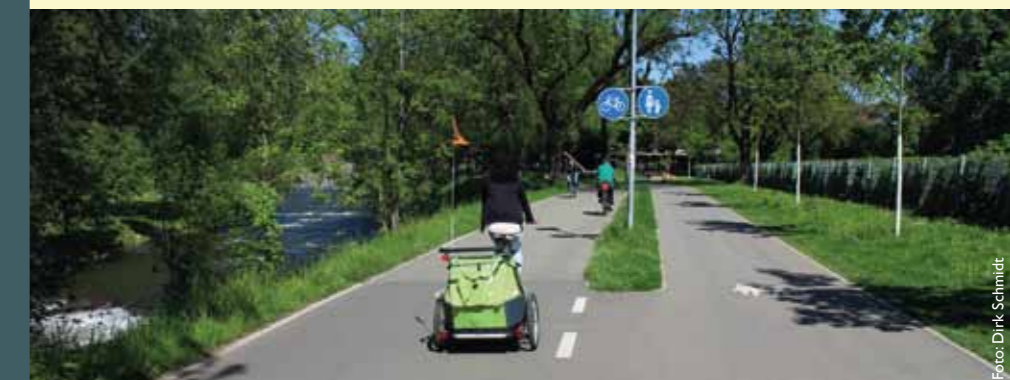
Beispiel 1 • Freiburg im Breisgau, Rad-Vorrang-Route FR1 „Dreisamuferweg“: Blick auf einen Abschnitt mit neuer Trennung des Rad- und Fußverkehrs.
