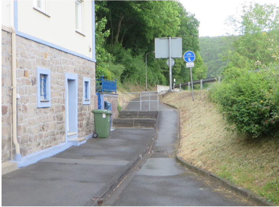
Abbildung 3.1 Beginn der benutzungspflichtigen Radverkehrsanlage an der B 83 am Ortsausgang Helmarshausen in Richtung Bad Karlshafen
