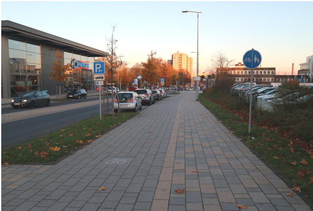
Abbildung 2.1 Radverkehrsanlage an der Friedrich-Ebert-Allee: Die Gestaltung ist grundsätzlich richtig: Bauliche Trennung von Rad- und Fußverkehr. Der Radbereich besitzt leider nur einen sehr dezenten Gestaltungsunterschied zum Gehbereich. Ferner fehlt eine taktil erfassbare Trennung zum Fußweg (laut ERA 2010 bei baulich angelegten getrennten Rad- und Gehwegen erforderlich). Beim evtl. nächsten Umbau: Im weiteren Verlauf der Friedrich-Ebert-Allee nach Westen sollten Rad- und Fußverkehr noch klarer baulich getrennt werden. Bild: Dirk Schmidt 11-2017
