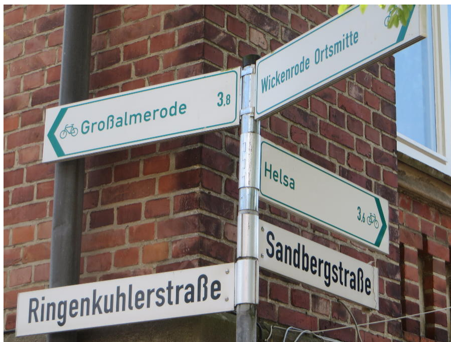
Abbildung 5.1 Radverkehrswegweisung in Wickenrode: entweder Schilderstandort bestimmungsgemäß verändern oder Wegweiser für alle relevanten Fahrbeziehungen sichtbar am vorhandenen Mast neu montieren
