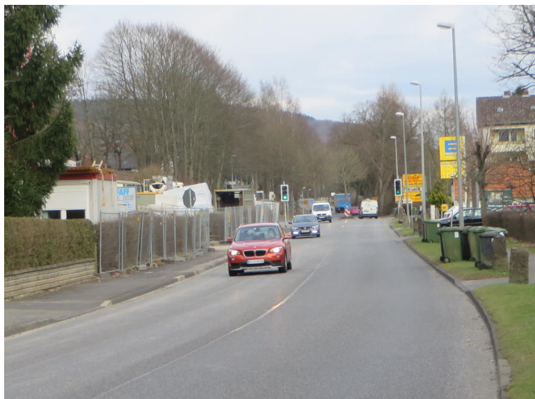
Abbildung 3.2 Ortsdurchfahrt B 451 in Helsa: Die Einkaufsmärkte sind für viele Radfahrer nur auf der Fahrbahn der Bundesstraße oder aber, verbotenerweise, über den Gehweg erreichbar.
