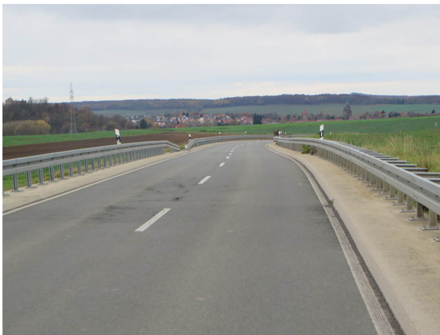
Abbildung 4.2 Gefährlich für den RV sind die zum Teil vorhandenen Hochborde mit beidseitigen Leitplanken außerorts. Im Gefahrenfall kann der RV hier noch nicht einmal mehr seitlich auf das Bankett ausweichen.
