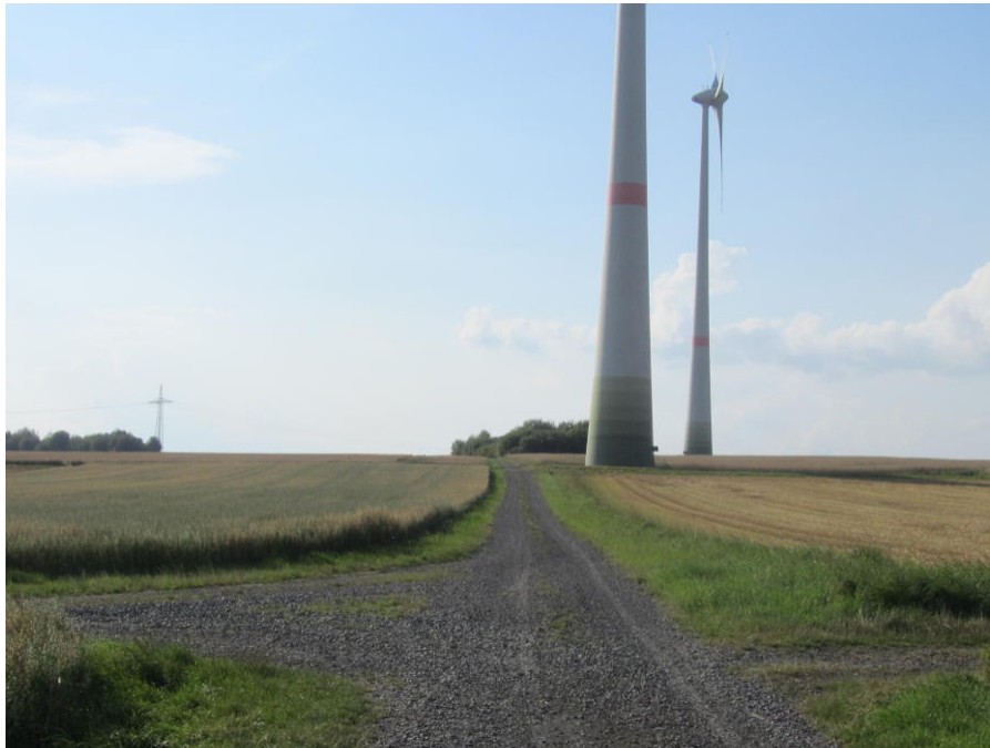
Abbildung 5.1 Windkraftanlagen und grob geschotterte Radverkehrsverbindung (Hessencourrierweg) bei Altenstädt.
