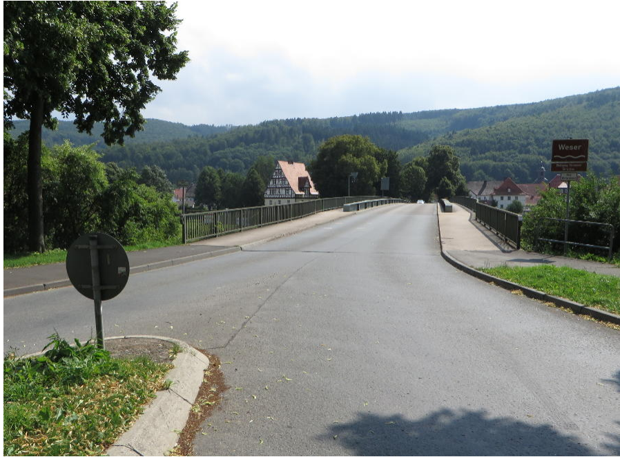
Abbildung 3.1 Blick über die Weserbrücke hinweg auf Gieselwerder: die meisten Radfahrer vermeiden die stärker verkehrsbelastete Brückenfahrbahn und nutzen stattdessen verbotenerweise die Gehwege
