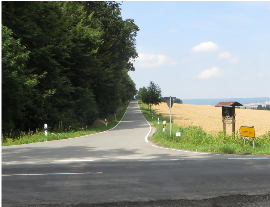
Abbildung 2.1 Die Kreisstraße K 82 mit Blick in Richtung Arenborn: wohl für die meisten Radfahrer ist eine Benutzung der nur 4 m breiten Fahrbahn, auf der keine Geschwindigkeitsbeschränkung angeordnet ist, zu unsicher
