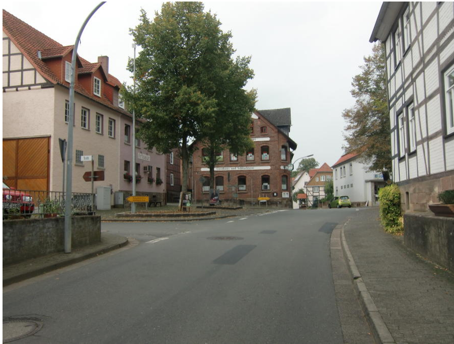
Abbildung 5.2 Ortsdurchfahrt L 3392 Vernawahlshausen: Radverkehr kann hier bei Tempo 50 nicht sicher geführt werden
