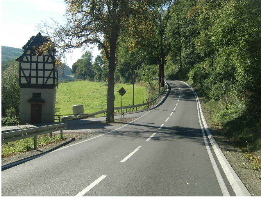
Abbildung 4.1 Das idyllische Warmetal mit dem Hessischen Radfernweg R 4 - kurvige Straße mit Leitplanken: Hier kann der RV im Gefahrenfall noch nicht einmal mehr schnell nach rechts ausweichen. An solch einer Strecke ist auch bei geringeren Verkehrsmengen klar eine vom KFZ-Verkehr getrennte Radroute notwendig.
