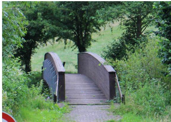
Bild 2: Dunkle Geländerstöße ohne Reflektoren
