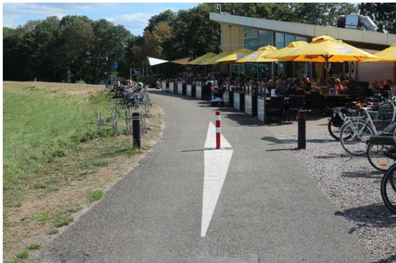
Bild 3: Beispiel Niederlande: Absicherung eines mittleren Sperrpfostens mit weißer Keilmarkierung
