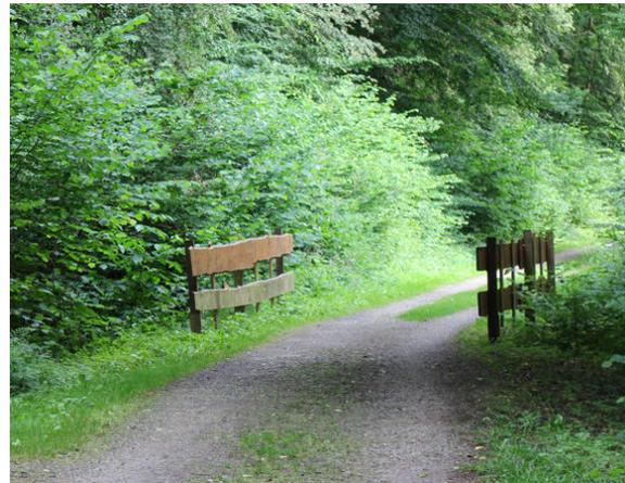
Bild 2: Blick auf die Schottertrasse. Die Geländerstöße sind ferner mit Reflektoren zu versehen (siehe BADK\_15).
