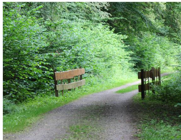
Bild 2: Insbesondere bei Dunkelheit schwer zu erkennen: die unmarkierten Brückengeländer
