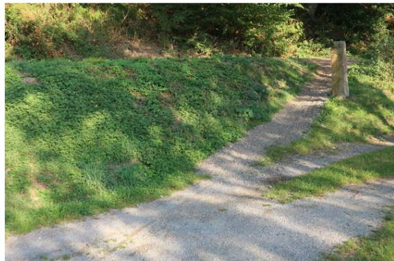
Bild 4: Rampe zwei ist ebenfalls zu schmal und auch loser Schotter
