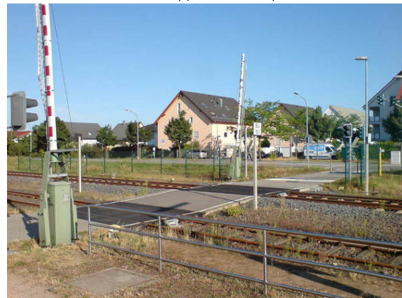
Bild 4: vorbildlich: Bahnübergang RV und FV mit eigener Schrankenanlage statt Umlaufsperrung
