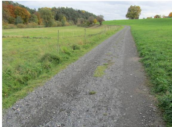
Bild 2: Blick auf die Schotterstrecke mit z. T. losem Belag.
