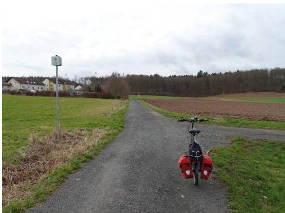
Bild 3: Schotterdecke im Verlauf: in 2020 befriedigend Fahrbar. Bei Landwirtschaftlichen Wegen kann sich der Zustand der Schotterdecke allerdings schnell ändern. Daher hier Asphaltdecke sinnvoll.
