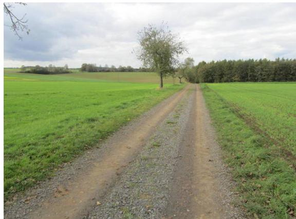
Bild 2: Schotterdecke mit Spurwegcharakter für Gespanne (Kinderanhänger) und Mehrspurer. Dadurch holpriger Fahrweg. Für ungeübten RV durch losen Schotter evtl. auch Sturzgefahr.
