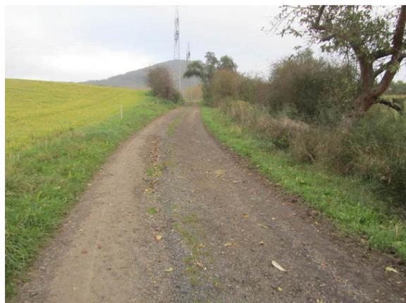
Bild 2: Blick bergwärts auf Bereich mit Errosionsrinne.
