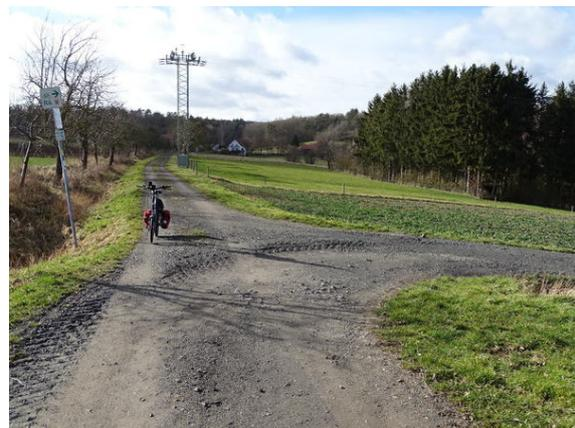
Bild 2: Abzweig Schotterstrecke nach Leckringhausen. z. T. trotz feuchter Witterung loser Grobschotter im Kurvenbereich.
