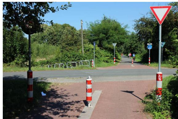
Bild 4: gesehen in NRW: Sperre aus drei Rundbaken mit zwei Fahrspuren für den RV.
