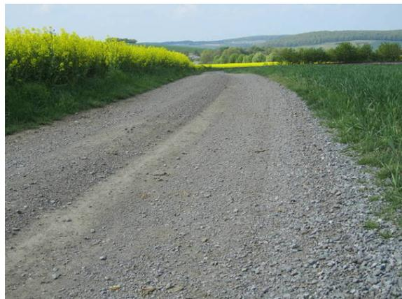
Bild 2: Blick auf die Schotterstrecke mit losem Belag. Es besteht vor allem für ungeübte Radfahrer Sturzgefahr!
