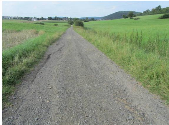
Bild 2: Blickrichtung Wolfhagen: lose Schotterstrecke mit Erosionsrinnen im Gefälle
