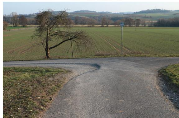
Bild 4: Beispiel für die angesprochene Gefahrenstelle „offenes Bankett in Kurvenlage“. Auf der im Bild ansonsten gut ausgebauten Radroute trotz Fahrradlicht vor allem bei Dunkelheit eine tückige Gefahrenstelle. Lösung: Kurvenbereich großzügig ausaspalten.
