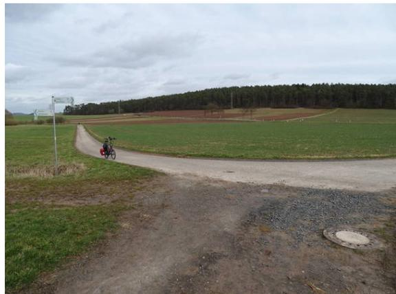
Bild 2: Beginn Schotterstrecke am R 4. Vorne rechts in 02-2020 mit einem hervorstehenden Kanaldecke noch potentielle Sturzstelle.
