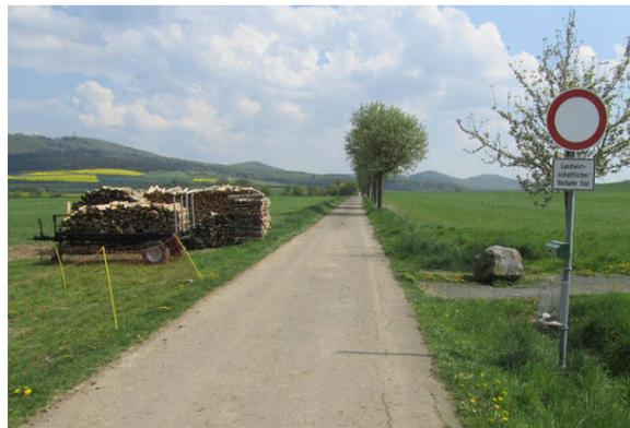
Bild 2: Zusatzzeichen 1022-10 unter der bestehenden Wegwidmung ergänzen. Rechts der graue Felsbrocken ohne Signalwirkung.
