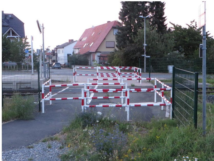
Abbildung 4.2 Schienenübergang für den Radverkehr am Regionalbahnhof Calden-Fürstenwald: an einer regionalen Hauptverbindung des Radverkehrs sollte eine automatische Schrankenanlage der Standard sein (CAL_26)
