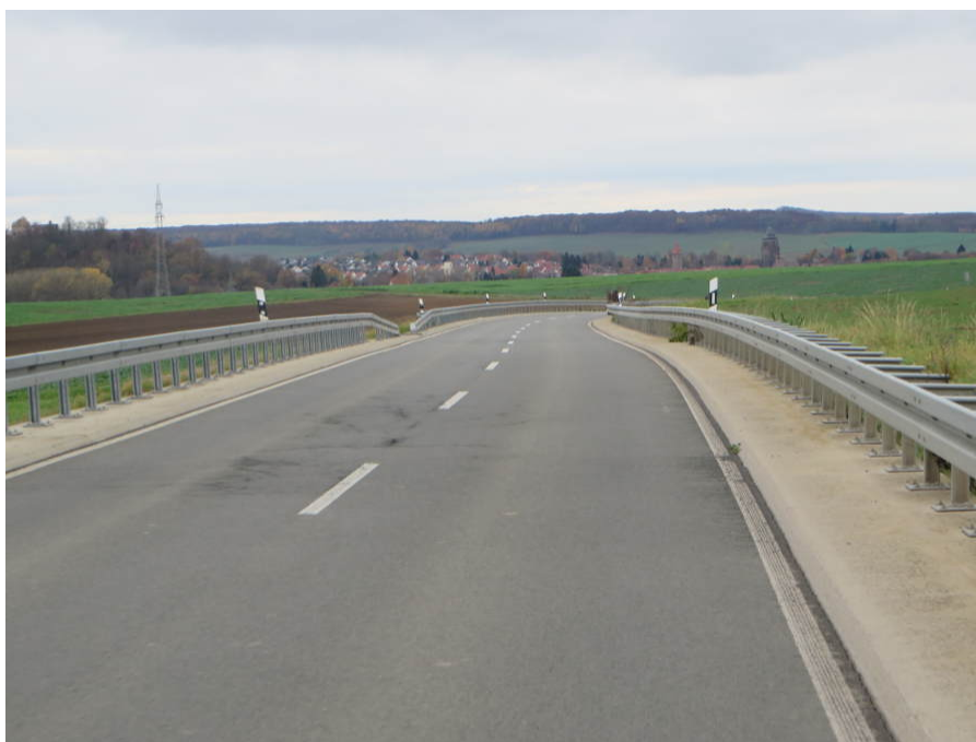
Abbildung 4.4 Gefährlich für den RV sind die zum Teil vorhandenen Hochborde mit beidseitigen Leitplanken außerorts. Im Gefahrenfall kann der RV hier noch nicht einmal mehr seitlich auf das Bankett ausweichen (Bild: Herbert Iba).
