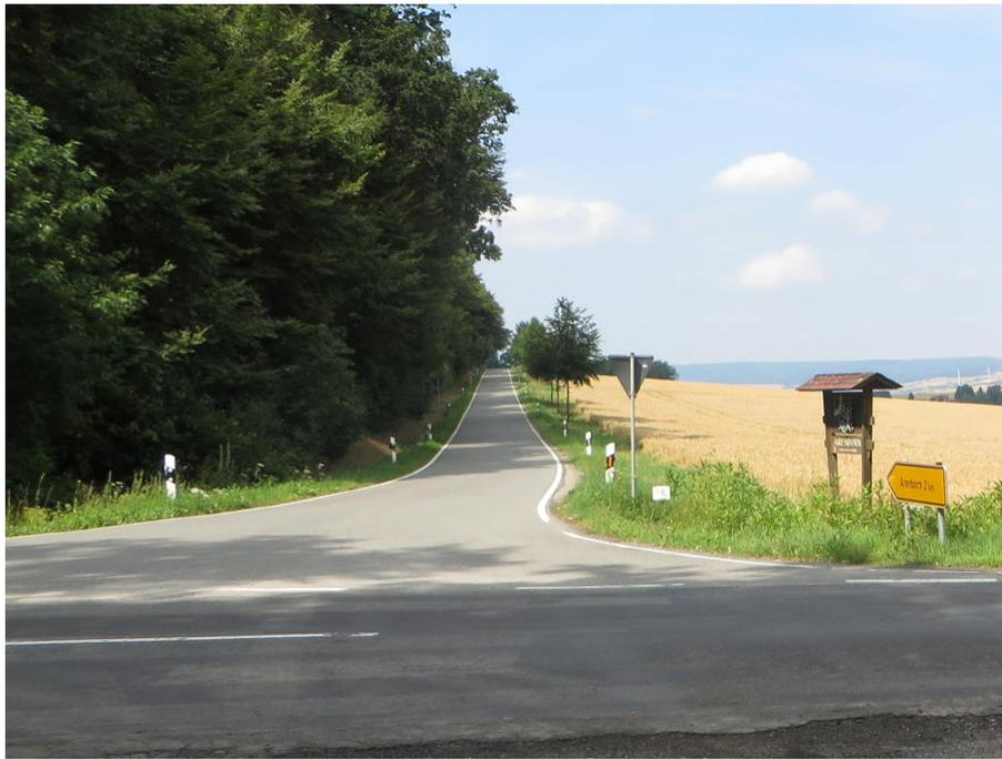
**Abbildung 2.1** Die Kreisstraße K 82 mit Blick in Richtung Arenborn: wohl für die meisten Radfahrer ist eine Benutzung der nur 4 m breiten Fahrbahn, auf der keine Geschwindigkeitsbeschränkung angeordnet ist, zu unsicher
